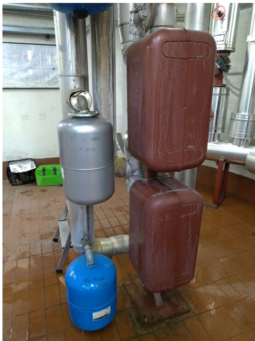
Fig. 3 – sottostazione W: batteria scambiatori produzione acqua calda sanitaria
