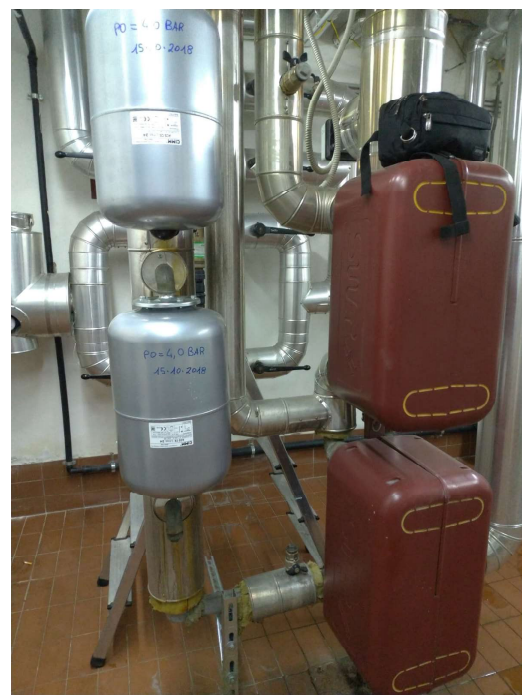
Fig 4 - sottostazione E: batteria scambiatori produzione acqua calda sanitaria
